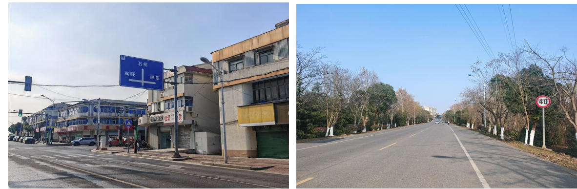
X204江星桥线现状标志标线
