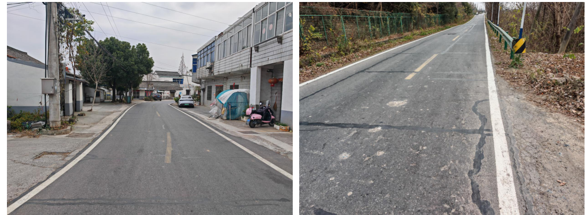
X162 星石线城镇段现状市政排水，公路段现状路面散排
