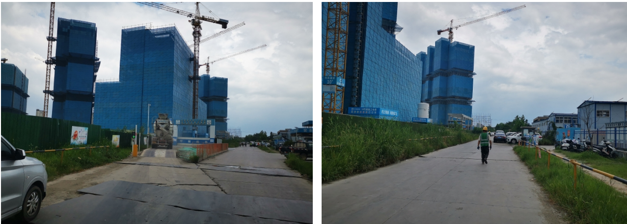
图 5-3 兰桥八期经济适用房地块建设现状
