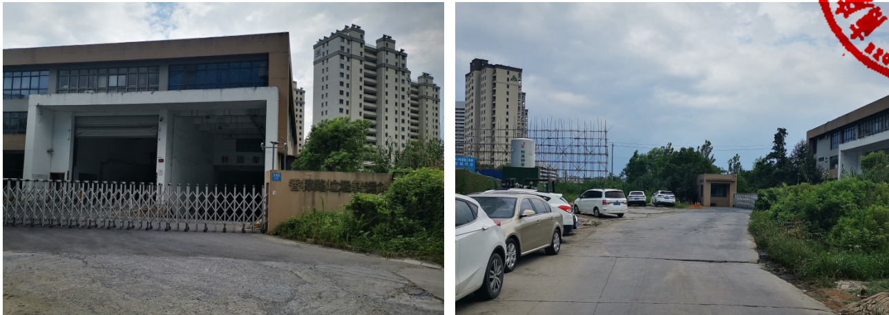
图 5-4 青柳路垃圾转运站现状
