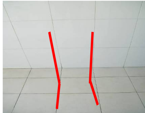
墙面砖缝与地面砖缝对齐
