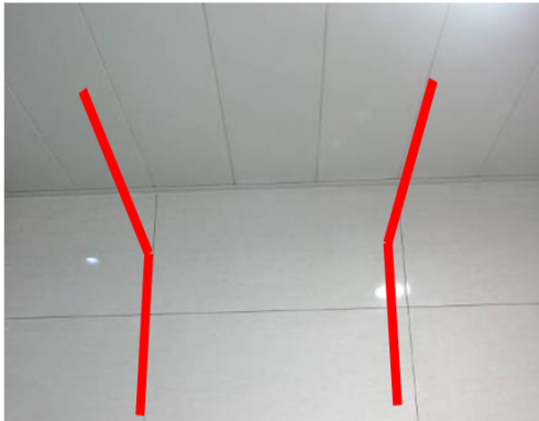
卫生间吊顶铝板与墙砖缝对齐
