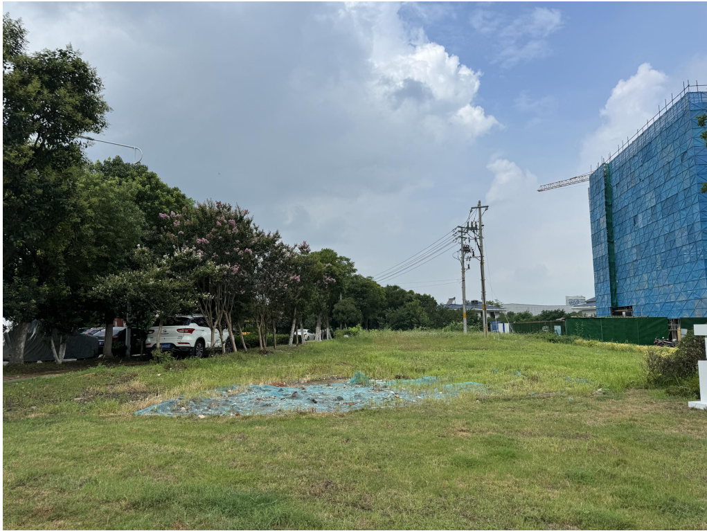
图 7-4 电力配电房现状图
