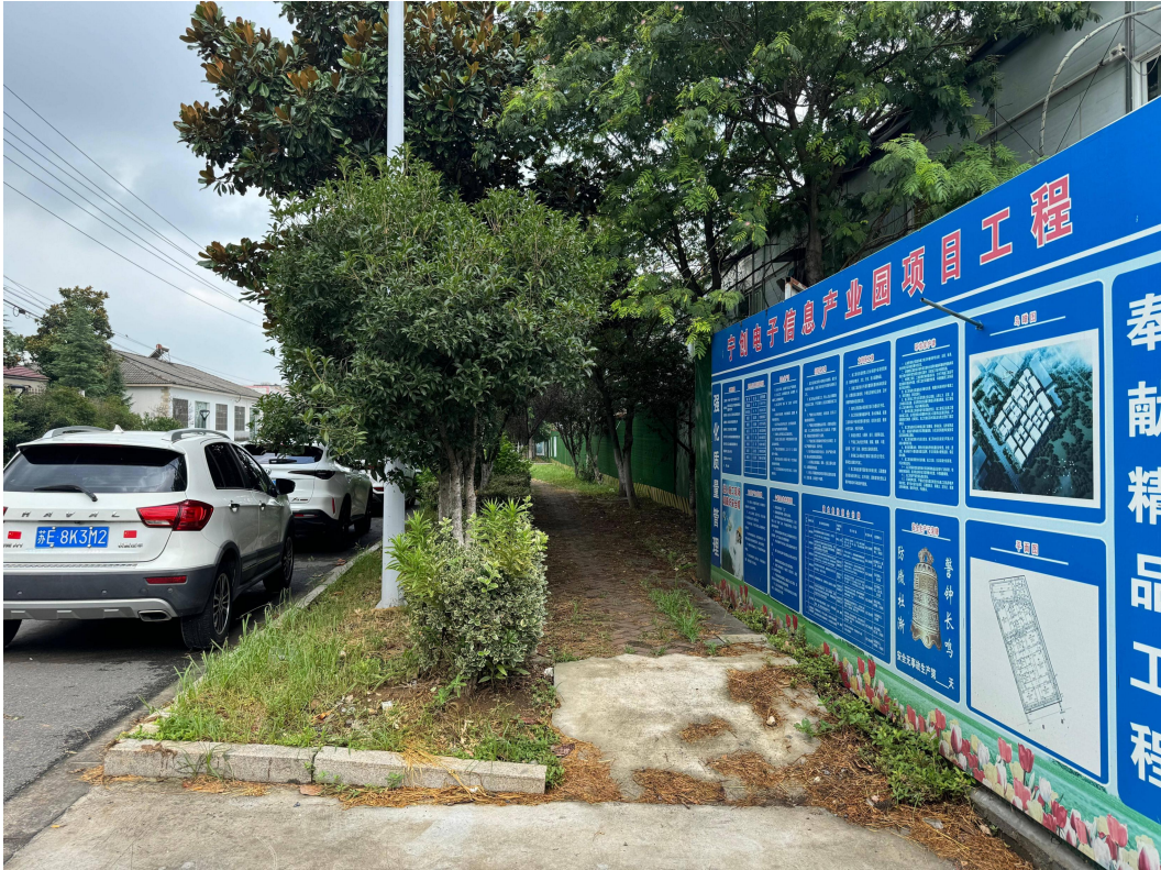
图 7-5 面包砖破损现状图
