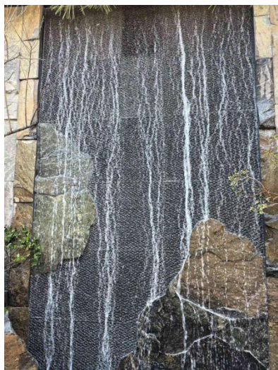
景石与景石之间接缝要求自然，根据效果要求对部分景石交接位置切槽处理，景石间用嵌套形式交接 墙面景石与水景流水板交接对标效果
