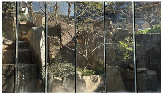
景石与景石之间接缝要求自然，根据效果要求对部分景石交接位置切槽处理，景石间用嵌套形式交接 墙面景石与水景流水板交接对标效果
