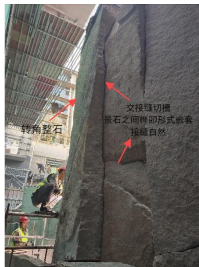
景石与景石之间接缝要求自然，根据效果要求对部分景石交接位置切槽处理，景石间用嵌套形式交接 墙面景石与水景流水板交接对标效果
