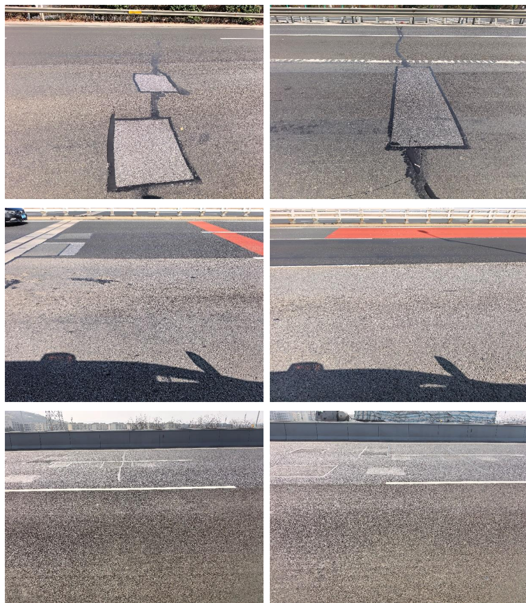
图 3.7-2 绕越高速四桥段现场调查
